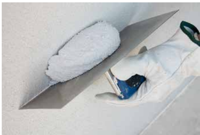
Aplikace hladicí zednickou lžící
